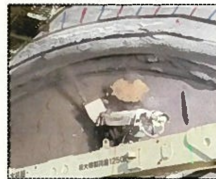
《掘削断面における天端抜け落ち状況》
